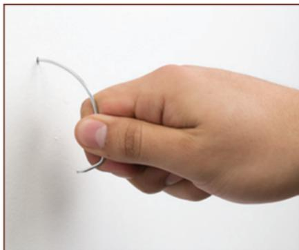
**Step 2.** Insert j hook at the determined location. **Étape 2.** Insérer le crochet. **Paso 2.** Insertar el gancho en la posición determinada.
