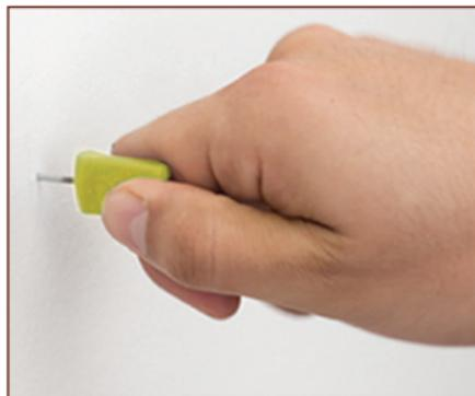
**Step 1.** Firmly push thumbsaver into marked locations while twisting back and forth until tip penetrates wall completely. **Étape 1.** À l'endroit voulu, appuyer fermement sur l'outil de pré-perçage en le tournant vers la droite et la gauche jusqu'à ce que la pointe traverse le mur. **Paso 1.** En la ubicación deseada, presionar firmemente la herramienta de preperforación girándola hacia la derecha y la izquierda hasta que la punta atraviese la pared.
