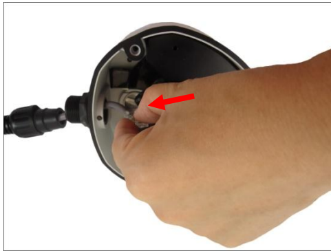
Using Flex Conduit
